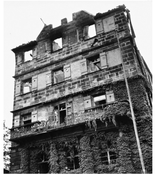
Das durch Luftminen stark beschädigte Zeltner Schloss, Fotografie 1943.
