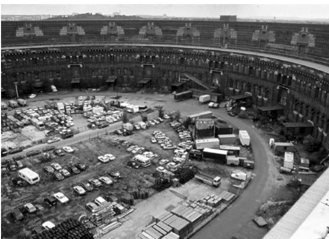
Der Innenhof mit abgeschleppten Fahrzeugen, Fotografie 2000.
