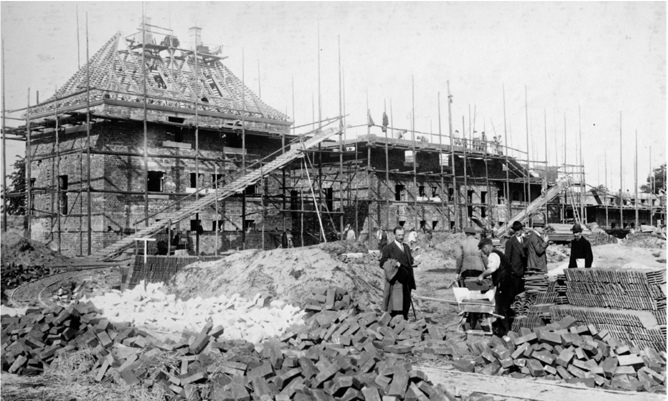
Die Siedlungshäuser, hier die Gartenseite der Gebäude an der Ziegelsteinstraße, wurden aus Ziegelsteinen, Tür- und Fensterstürze sowie die Sockel aus Buchenbühler Sandstein gefertigt. Für Stallbauten und Giebeltrennwände nutzte man billige Ersatzstoffe wie Geschoskörbe. Fotografie 1919.
